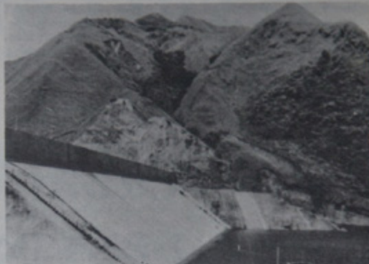
Aquí se represan las aguas del río Cauca, por lo cual se inundará más de 20 kms a lo largo de éste.
